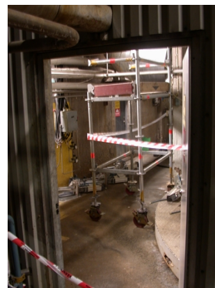
Tillfällig avspärning vid högtrycksspölning
